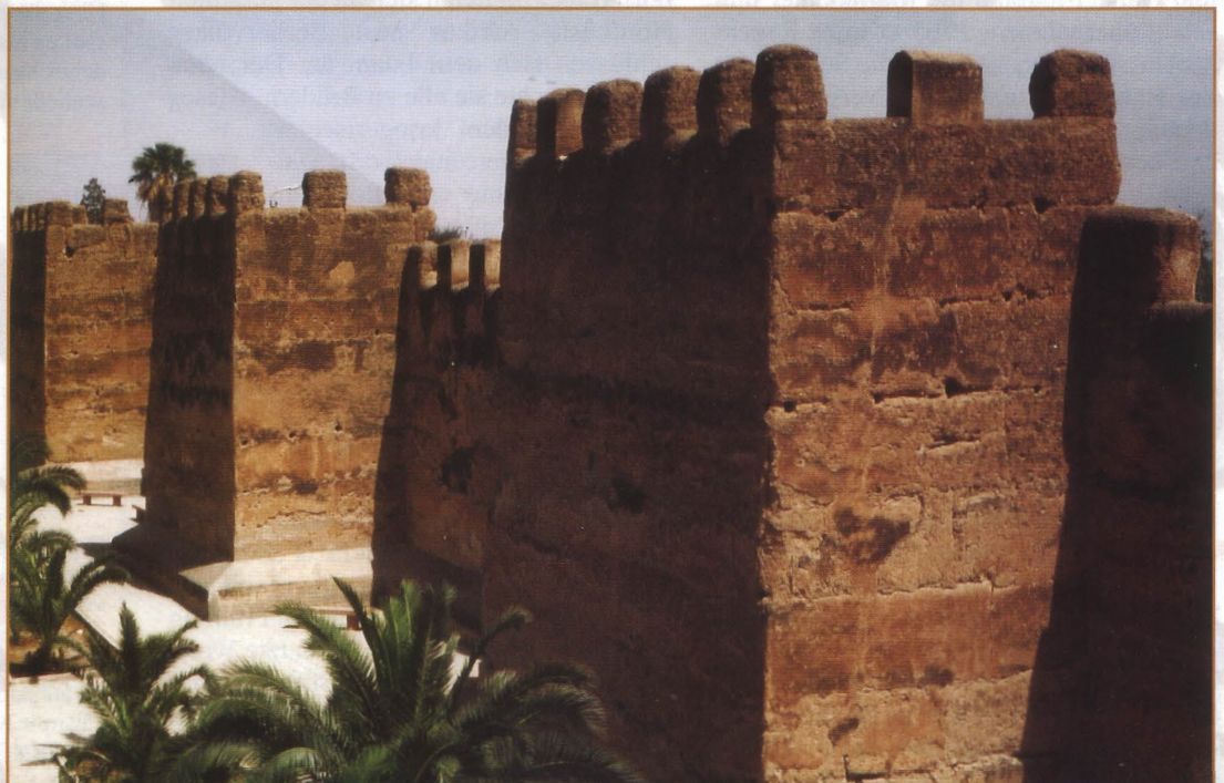
Taroudant, früher eine der reichsten Städte Marokkos, umgeben von einer starken Befestigungsmauer, die noch heute 10m hoch und 2m dick ist.
